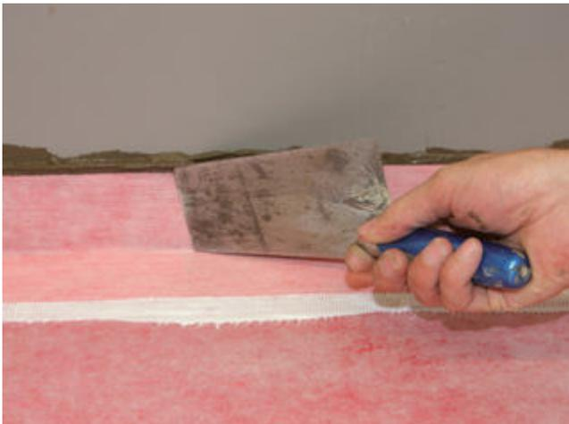
15) ... und mit einer Kelle oder einem Malerrollen-Bügel andrücken. Überschüssigen Kleber auf der Wand entfernen oder zur Wand hin absachteln.
