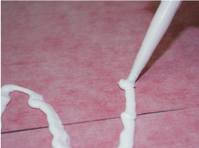
7) Im Stoßbereich Sopro Racofix® Montagekleber etwas breiter als Sopro AEB® Dichtband (120 mm) schlangenförmig auftragen ...
