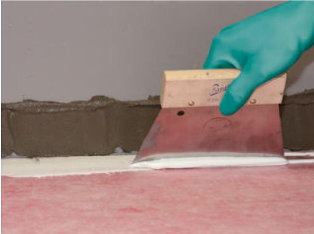
13) Auf die an die Wand grenzende Sopro AEB® plus wird ein im System geprüfter Kleber aufgerollt oder mit einem Spachtel fein aufgekämmt.
