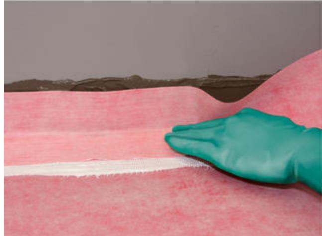
14) Ein im System geprüftes AEB® Dichtband in das offene Kleberbett einlegen.
