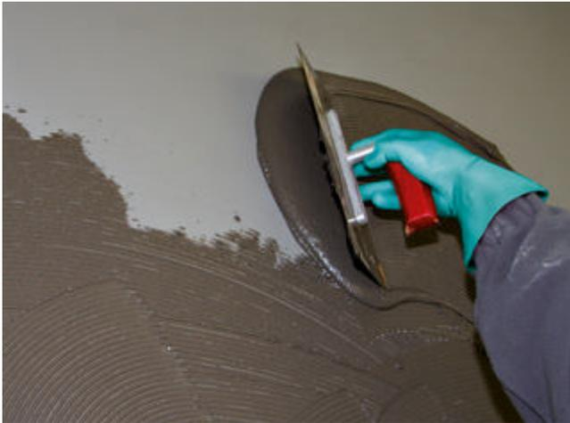
3) Aufkämmen von Sopro megaFlex S2 turbo mit der entsprechenden Zahnkelle. (Alternativ kann zur Bahnenverklebung auch FDK 415 oder DSF RS aufgerollt werden)
