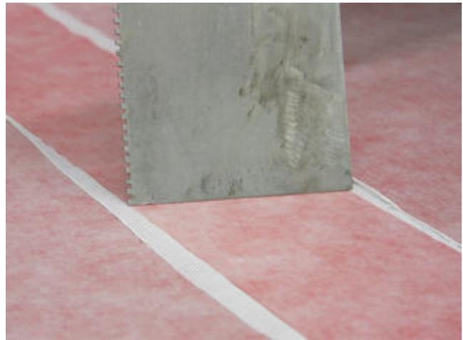
10) Das zugeschnittene Sopro AEB® Dichtband mit der glatten Seite der Zahnkelle andrücken und so abstreichen, dass keine Lufteinschlüsse unter der Bahn verbleiben.
