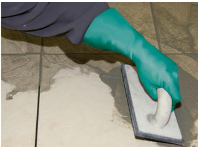
17) ... und nach Erreichen der Begeh- und Verfugbarkeit des Verlegemörtels mit z. B. Sopro DF 10®, Sopro FlexFuge plus oder Sopro FlexFuge FL verfugt werden.
