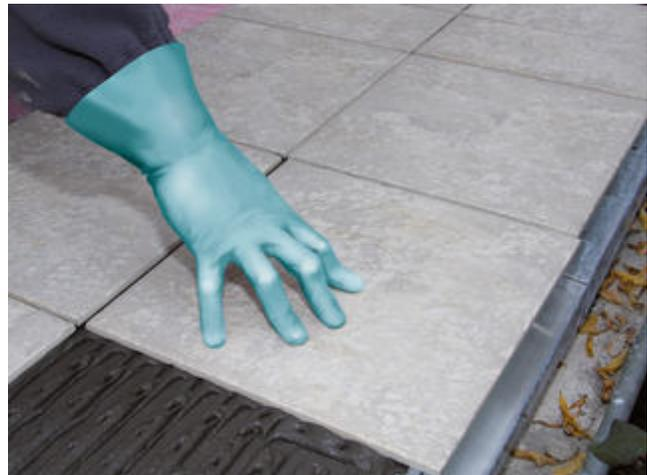
16) Keramische Fliesen können anschließend ohne lange Wartezeiten im Bodenbereich mit Sopro megaFlex S2 turbo direkt auf Sopro AEB® plus verlegt...
