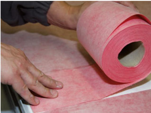
9) Anschließend wird Sopro AEB® Dichtband in das Kleberbett eingelegt und der Stoßbereich überklebt.
