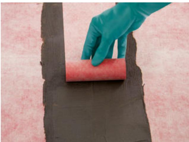
11) Alternativ kann auch FDK 415, DSF RS, TDS 823, WB 588 oder MKS 819 im Stoßbereich aufgetragen werden. Sopro AEB® turbo mit einer Kelle aufspachteln. Dichtband einlegen und den Stoßbereich überkleben.
