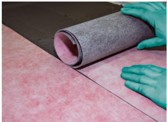
6) Die anschließende zweite Bahn wird stumpf stoßend an die erste Bahn verklebt.
