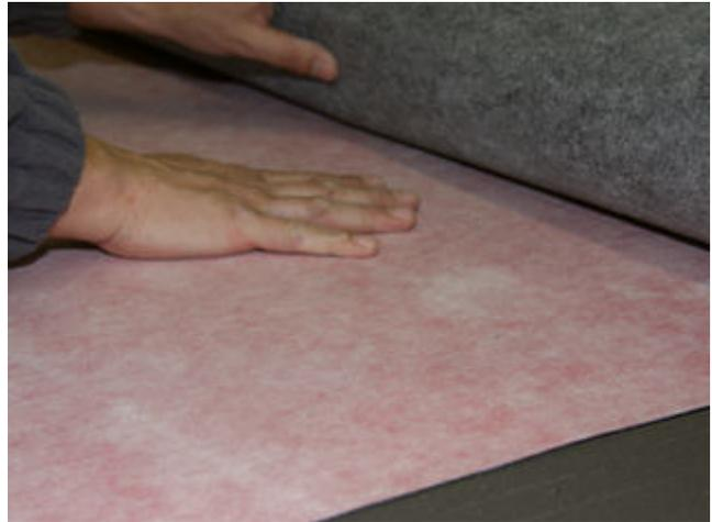
4) Die passgenau zugeschnittenen, einzelnen Bahnen der Sopro AEB® plus werden mit der grauen Seite nach unten vollflächig in das frische Klebebett eingelegt.
