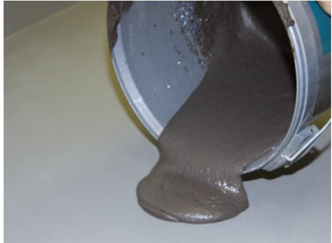
2) Ausgießen des Fließbettmörtels megaFlex S2 turbo auf den ebenflächigen, tragfähigen und sauberen Untergrund.
