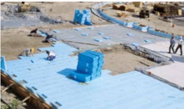
Abb.09: XPS Dämmplatten lose auf der Beton-Sauberkeitsschicht verlegt
