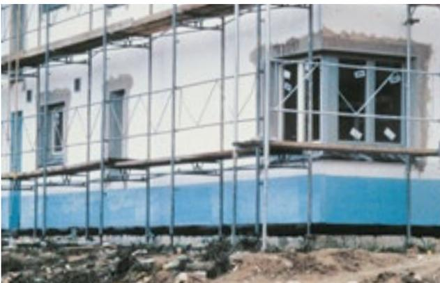
Abb. 23: Widerstandsfähige Wärmedämmung aus XPS gegen Spritzwasser und mechanische Beanspruchung im Sockelbereich
