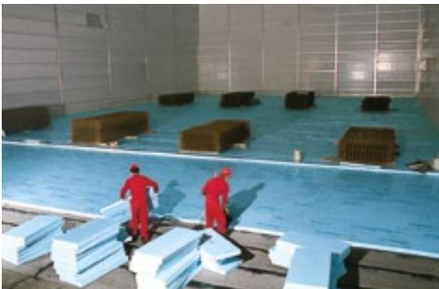
Abb. 38: XPS Bodendämmung in einem Tiefkühlhaus
