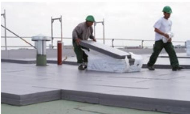
Abb. 14: RAVATHERM™ Platten werden zweilagig verlegt
