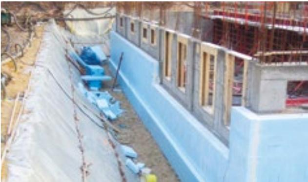
Abb.07: Dämmplatten zweilagig auf der Kelleraußenwand verklebt
