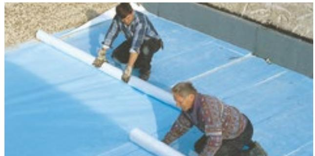
Abb. 22: Verlegung der Trennlage
