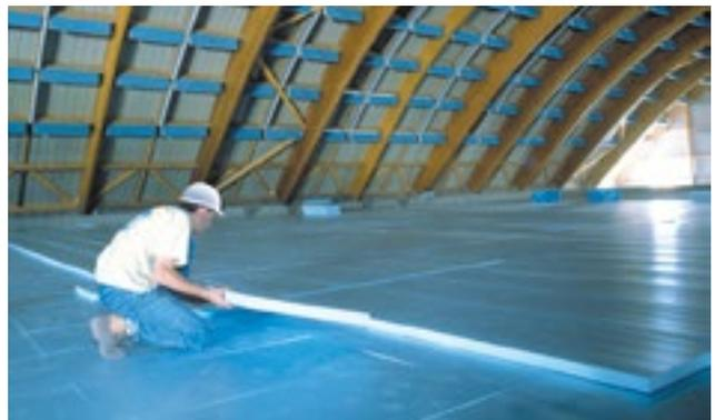
Abb. 45: XPS-Bodendämmung in einer Sporthalle
