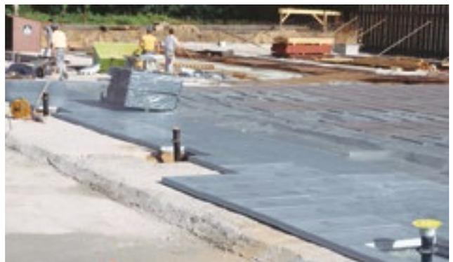
Abb.12: Dämmplatten auf der Beton-Sauberkeitsschicht verlegt
