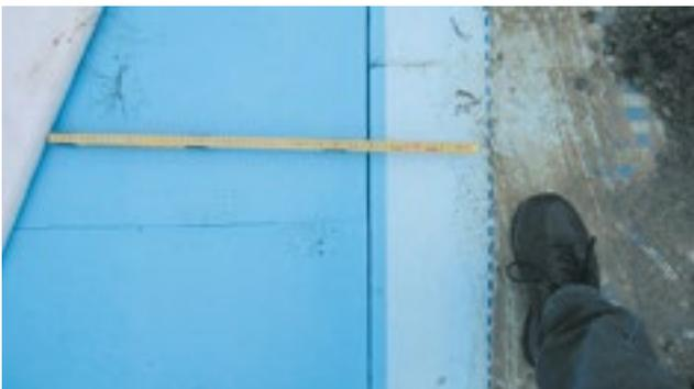
Abb.52: Die freigelegte XPS Platte zeigt so gut wie keine Ablagerungen auf der Oberfläche
