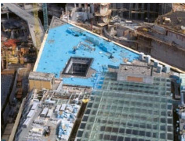
Abb. 18: Umkehrdach auf dem Daimler-Chrysler-Haus in Berlin
