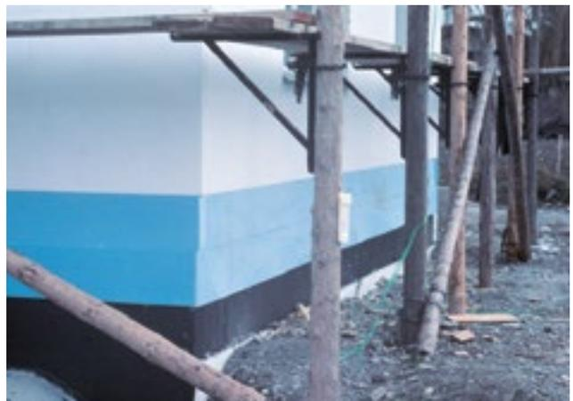
Abb. 43: XPS-Sockeldämmung im Spritzwasserbereich
