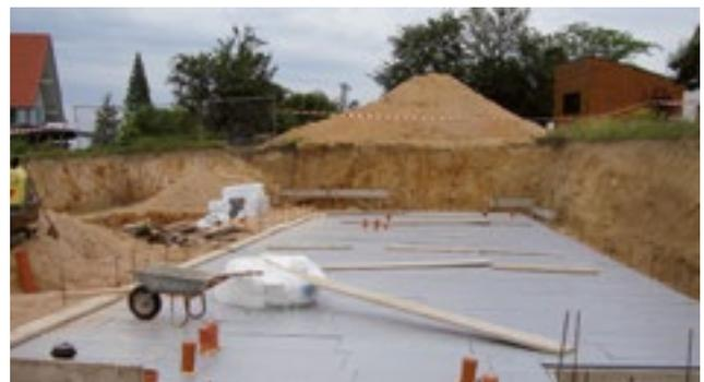
Abb. 19: Verlegung XPS-Dämmplatten unter lastabtragender Bodenplatte
