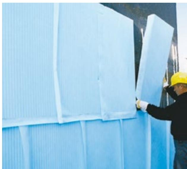
Abb. 34: Verlegung der blauen XPS Dämm-/Dränelemente
