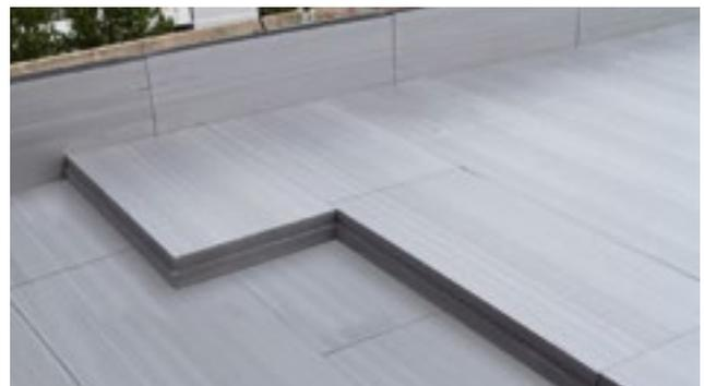
Abb. 27: Attika-Anschluss mit RAVATHERM™ XPS X
