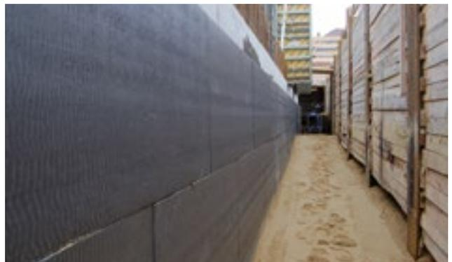
Abb.10: Graue XPS Dämmplatten auf der Kelleraußenwand verklebt
