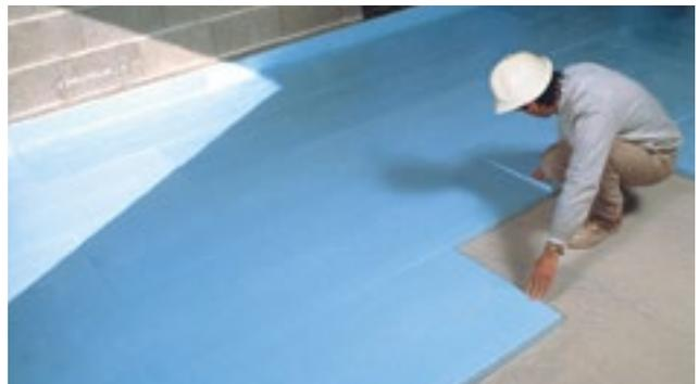
Abb. 46: XPS-Bodendämmung in einer Sporthalle
