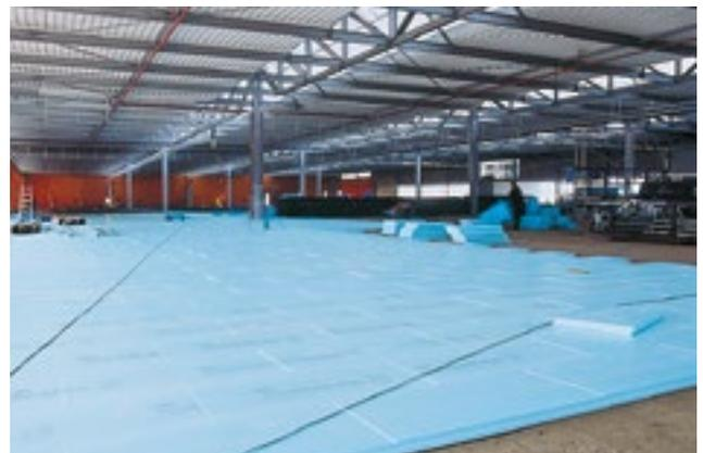
Abb. 39: XPS Bodendämmung in einer Werkshalle
