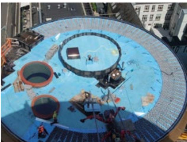
Abb. 16: XPS-Dämmplatten auf dem Dach vom Axeltorv-Haus, Kopenhagen
