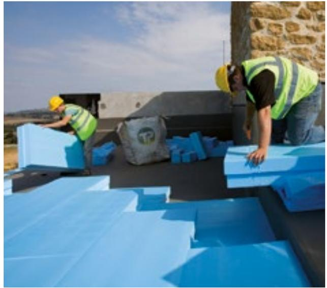
Abb. 21: Die doppellagige Verlegung von XPS Platten auf einer Sauberkeitsschicht aus Beton
