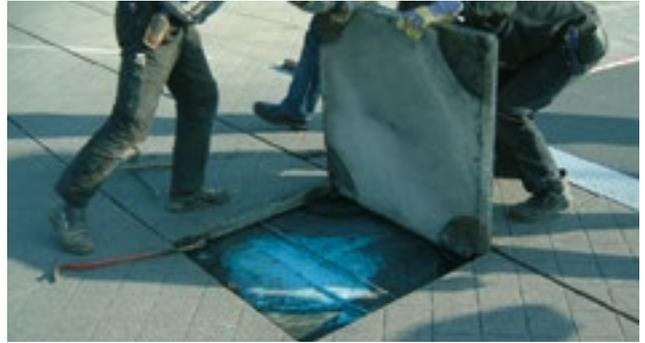
Abb.49: Entnahme der blauen XPS Dämmplatte ...
