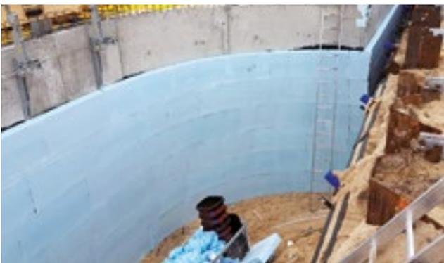
Abb.11: Dämmplatten auf der Kelleraußenwand verklebt
