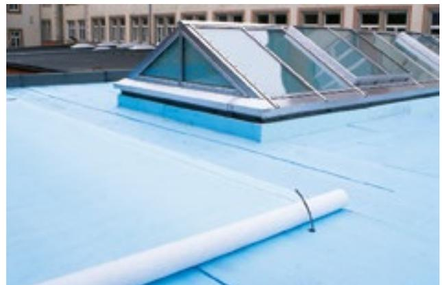
Abb. 28: Lose Verlegung der Trennlage
