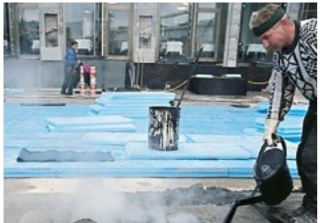
Abb. 11: Verlegebeispiel einer bituminösen, vollflächig verklebten Abdichtung
