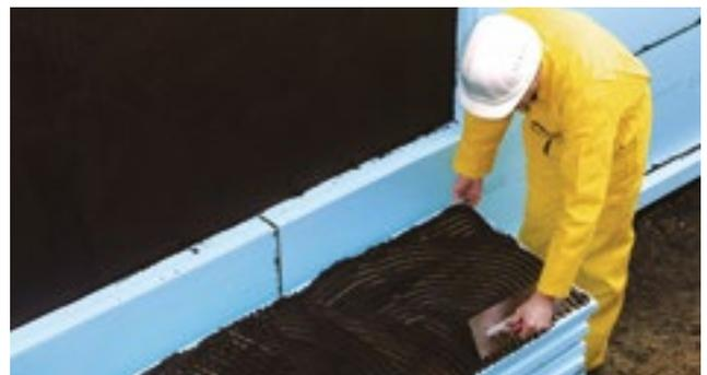
Abb. 32: Vollflächige Verklebung der blauen XPS Dämmung
