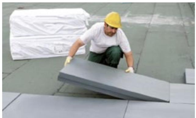
Abb. 44: XPS Platten lassen sich leicht handhaben
