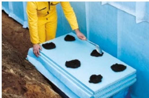
Abb. 28: Punktweise Verklebung der Perimeterdämmung
