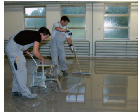
Der extrem leichte Verlauf von PCI Periplan<sup>®</sup> fein ermöglicht stehende Verarbeitung mit der Rakel für rationellen und planebenen Bodenausgleich.
