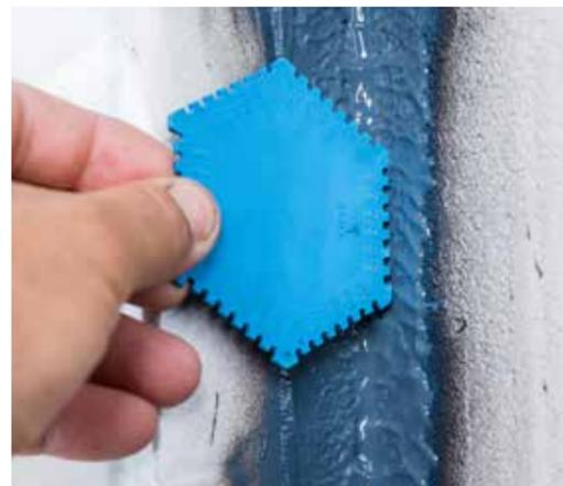
Während des Trocknens wechselt AEROSANA VISCONN die Farbe von blau zu schwarz. AEROSANA VISCONN white hat keinen Farbumschlag. Der feuchte Film ist vor Feuchtigkeit (z. B. Regen) bis zur vollständigen Durchtrocknung zu schützen.
