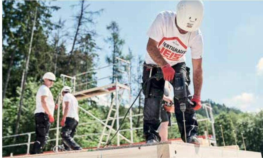
*Auf der Bodenplatte oder Kellerdecke werden zunächst die Erdgeschosswände und Deckenelemente sowie gegebenenfalls die Dachgeschosswände angebracht. Die Dachelemente können meist bereits am zweiten Tag mit den Dachsteinen eingedeckt werden – die Bauherren können das Richtfest feiern.*
