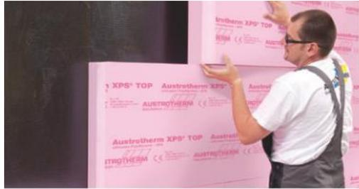
Druckfeste Wärmedämmplatte aus extrudiertem Polystyrolhartschaum mit **Stufenfalz (SF)**
